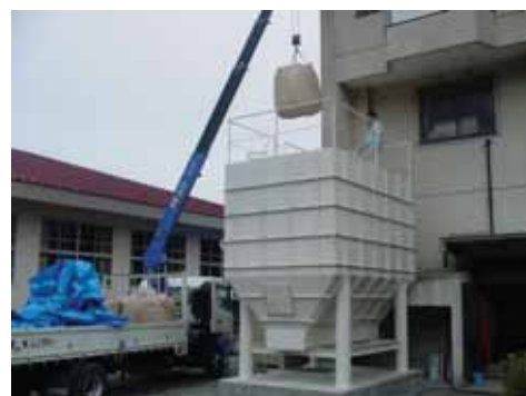
図 32 ペレット投入における高所作業
