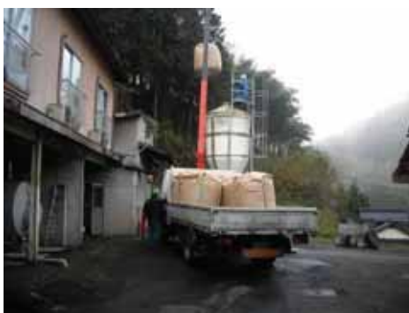
図 35 ユニック車での投入作業
