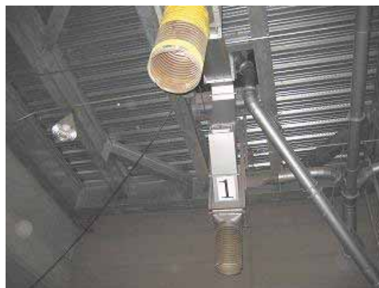
図 45 バルク車専用サイロの投入口
