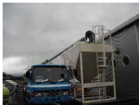
図 37 バルク車での投入作業
