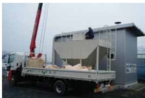
図 38 リモコンユニック車での投入作業
