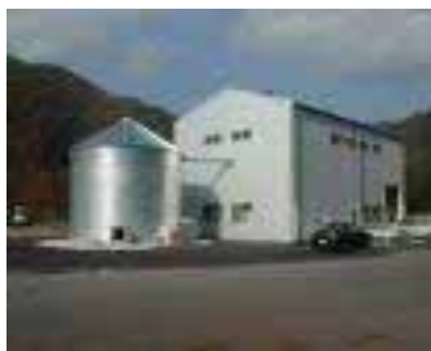
図1 ペレット工場施設外観
