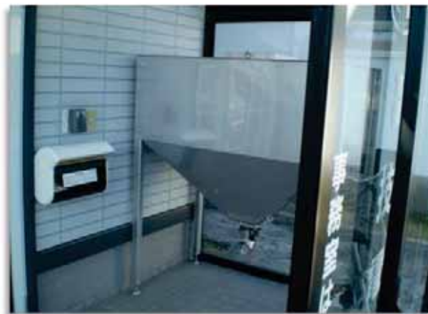
図表 3-3 木質ペレット貯蔵タンク（備蓄サイロ） 設置風景
