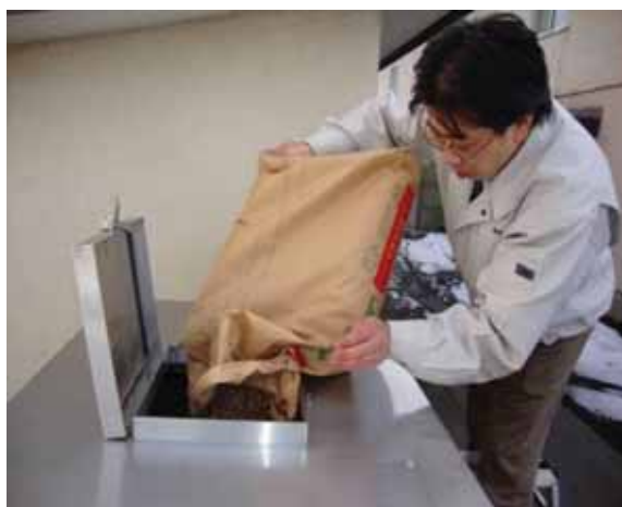
図表 3-4 木質ペレット貯蔵タンク（備蓄サイロ） ペレット補給風景
