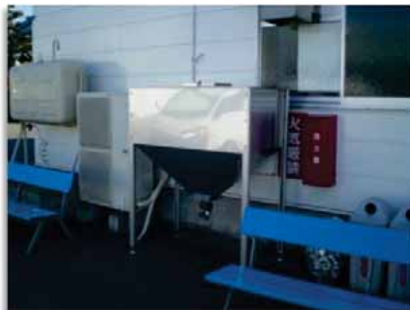
図表 3-3 木質ペレット貯蔵タンク（備蓄サイロ） 設置風景
